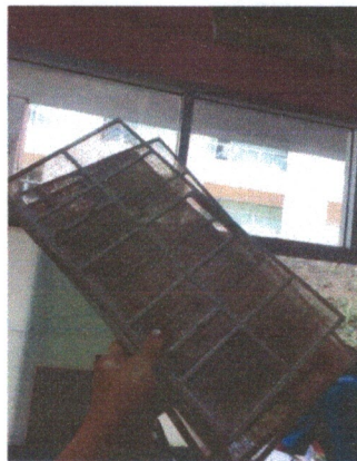
รูป การถอดแผ่นกรองอากาศและฟิวส์ชุดส่งลมเย็น
