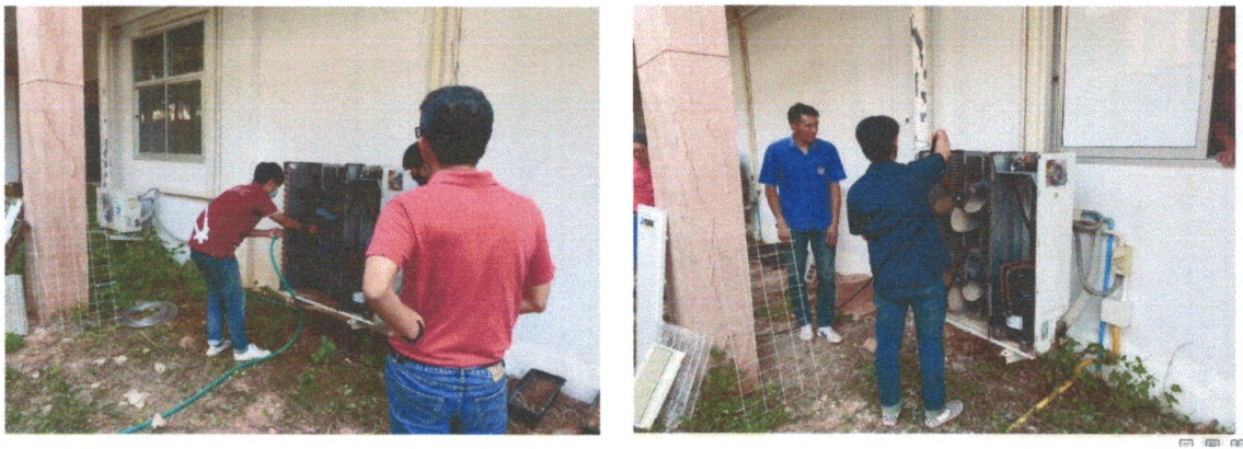
รูป การดำเนินการชุดระบายความร้อน (คอยล์ร้อน)
