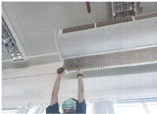
รูป การตรวจสอบคุณสมบัติสภาวะอากาศของเครื่องปรับอากาศ
