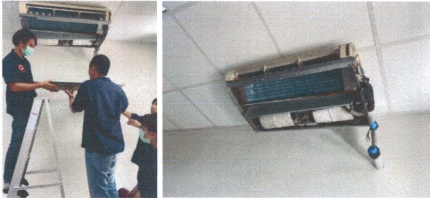
รูป การถอดถาดน้ำทิ้งออกจากตัวเครื่อง
